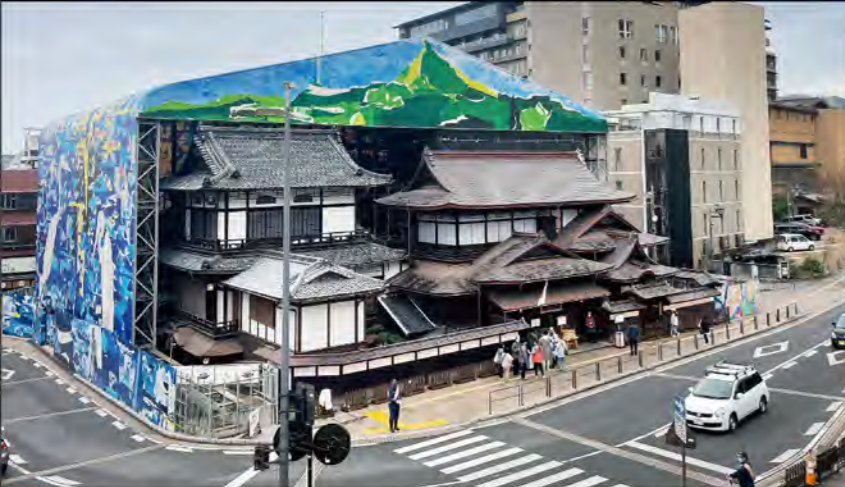
足湯「空の散歩道」から見た「道後温泉本館」。保存修理工事の様子や道後のまちを一望できます。保存修理工事は令和6年12月末完了予定
