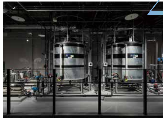
魚類用1基、ペンギン用1基の計2基の、人工海水を製造するプラント
